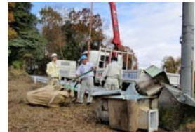
ユニック車で大型ゴミを回収
