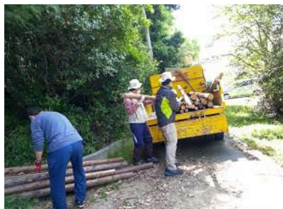
△木材の運び出し・市の車両による
